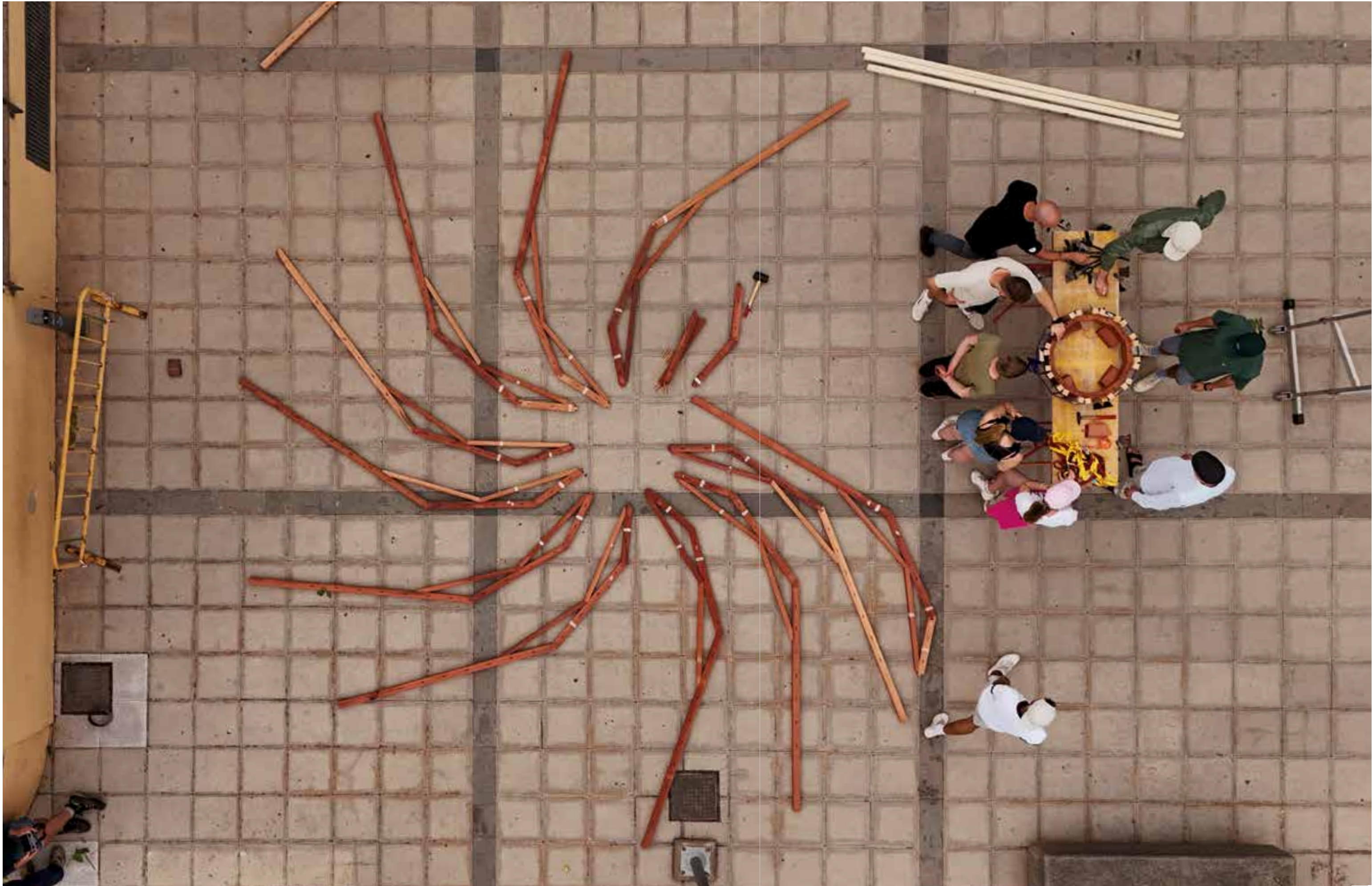
Los elementos de soporte, el arco de entrada y el anillo superior están listos para el montaje final, planificado con precisión.
