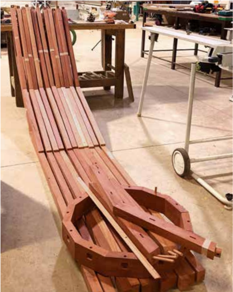
En la noche del penúltimo día del proyecto, todos los elementos de la construcción fueron finalmente revisados, clasificados y preparados para el transporte, como antesala del montaje final.
