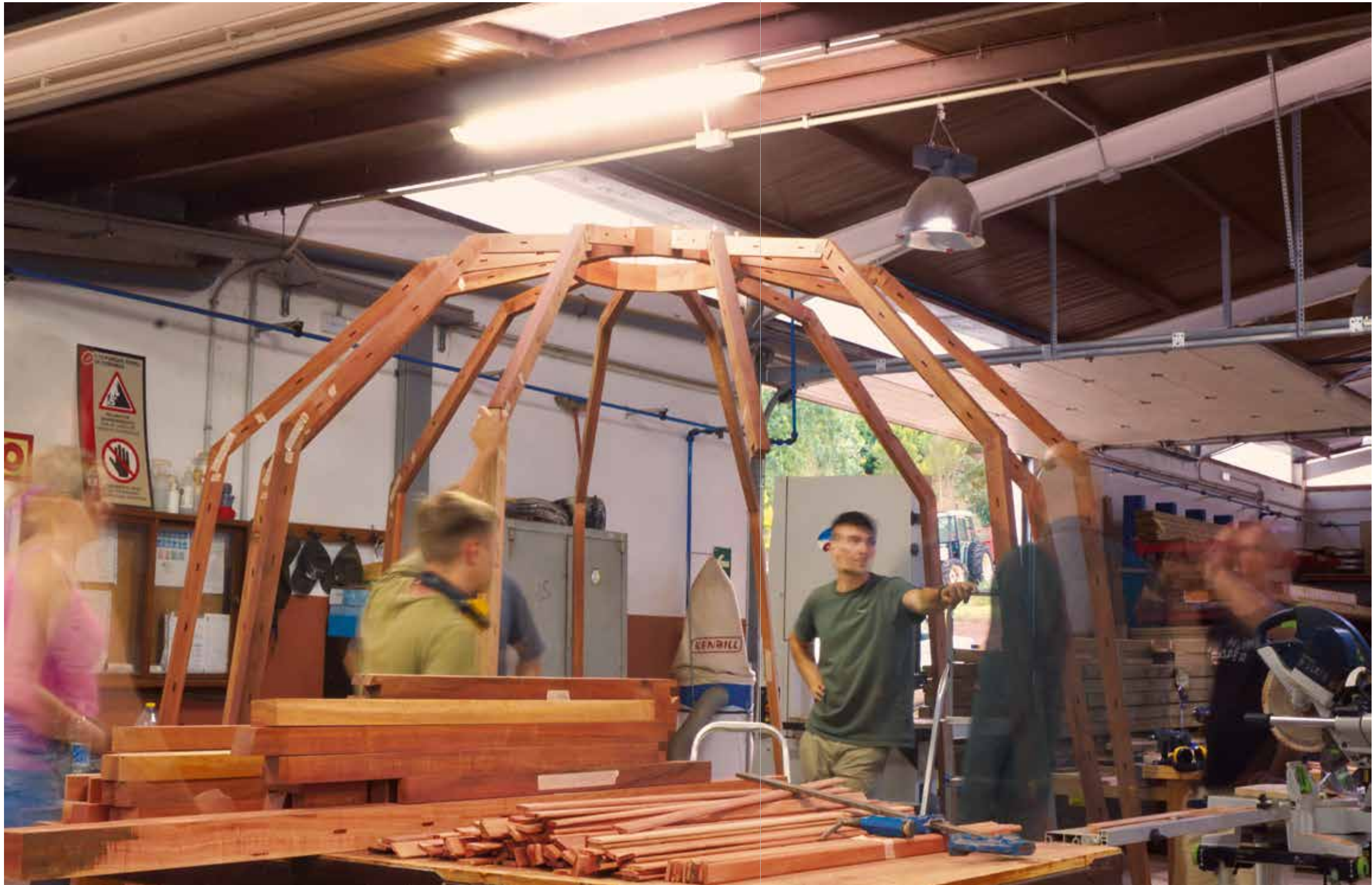
El primer ensamble de los elementos de soporte sin arriostamiento en el taller de Osorio permite planificar los siguientes pasos constructivos y practicar el montaje in situ.
