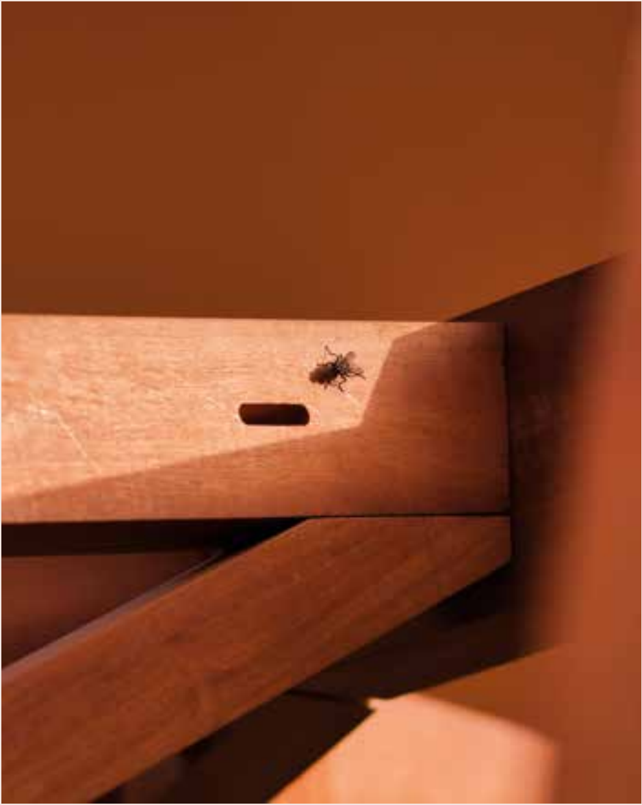
El anillo de compresión ocupa el extremo superior de los elementos de soporte y guía las cargas en un círculo. Los pequeños orificios ranurados se fresan como huecos delgados para insertar posteriormente las tabillas.
