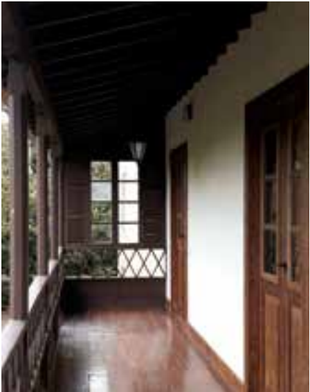
Balcones tradicionales y duraderos. La falta de disponibilidad de madera de tea de pinos centenarios, unido al nivel de protección de los pinarés maduros predestinan al eucalipto rojo como posible reemplazo.
