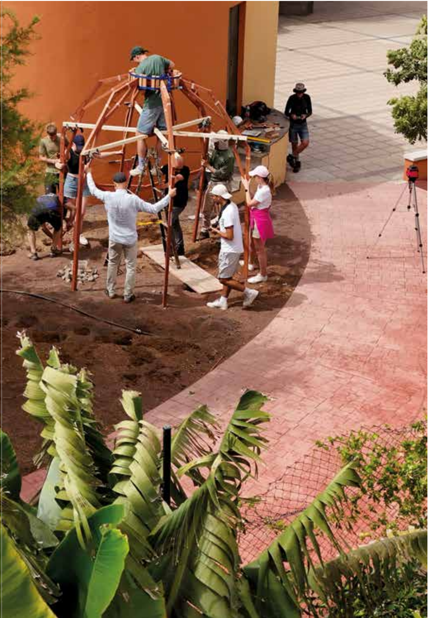
El equipo verificó la precisión de los ensambles de los listones de las patas y se prepararon los cimientos.
