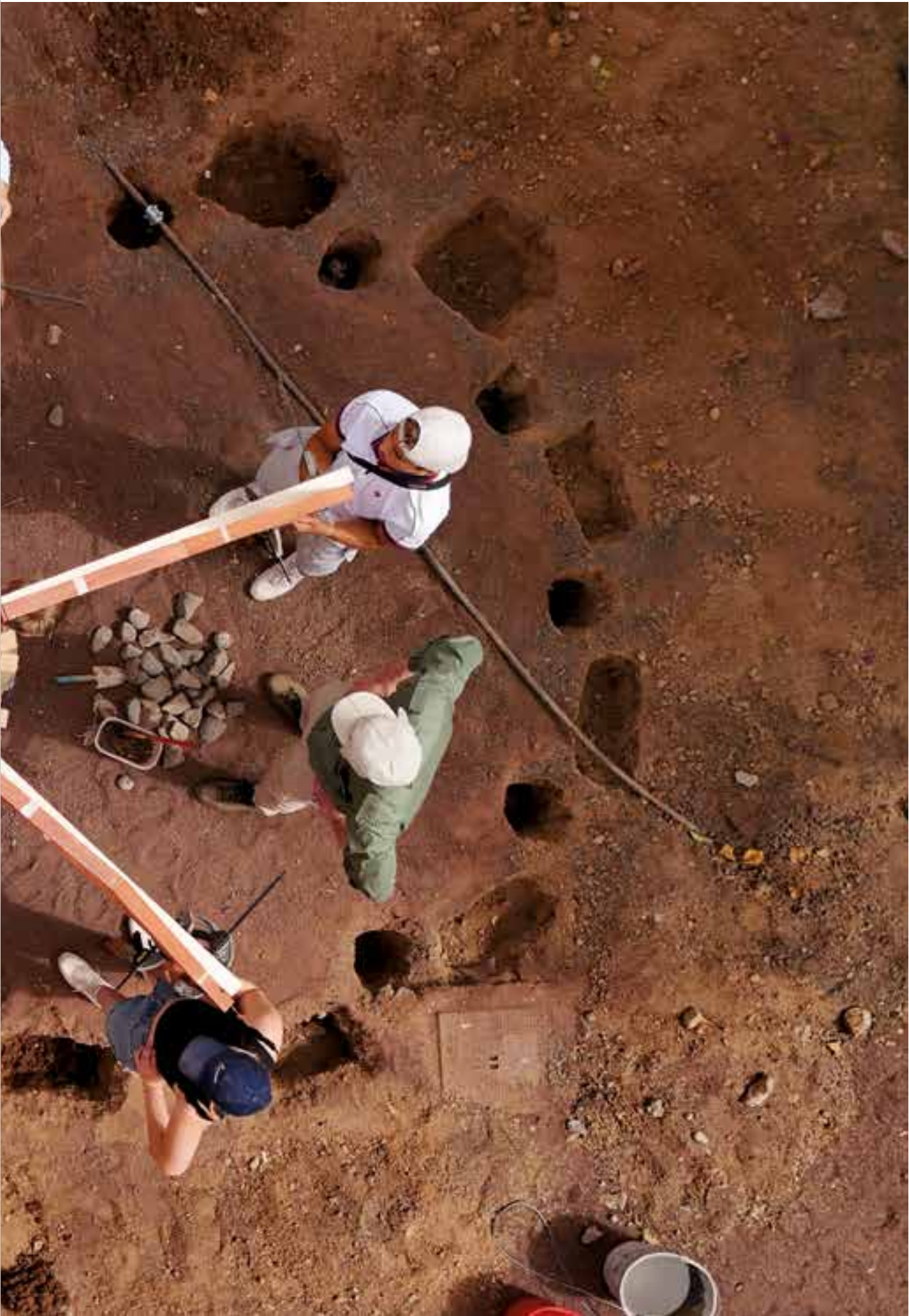
La estructura se soporta temporalmente con traviesas, hasta que se cimenten las patas en el suelo. Las varillas arriostarán finalmente la estructura, confiriéndole la rigidez.
