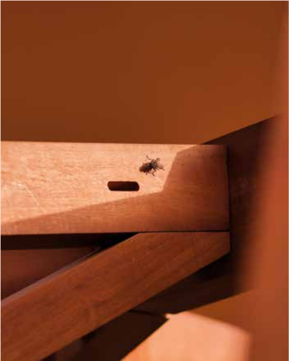
Der Druckring nimmt das obere Ende der Stützelemente auf und führt die Lasten im Kreis. Kleine Langlöcher sind als schlanke Vertiefungen eingefräst, um die Sprossen im Nachgang einzusetzen.
