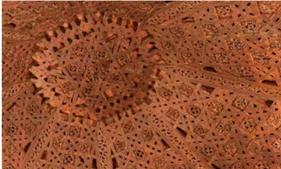
Die Kanaren sind dafür bekannt, im Laufe der Geschichte viel Holz für Bauzwecke verwendet zu haben. Besonders wurde das Kernholz der Kanaren-Altkiefern genutzt, um dauerhafte Konstruktionen wie Kirchendecken zu fertigen.
