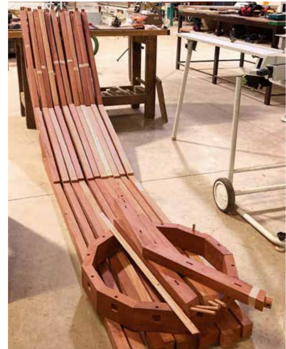
Für den Abtransport wurden am Abend des vorletzten Workshop-Tages alle Elemente der Konstruktion final überprüft und sortiert abgelegt, um die Endmontage vorzubereiten.
