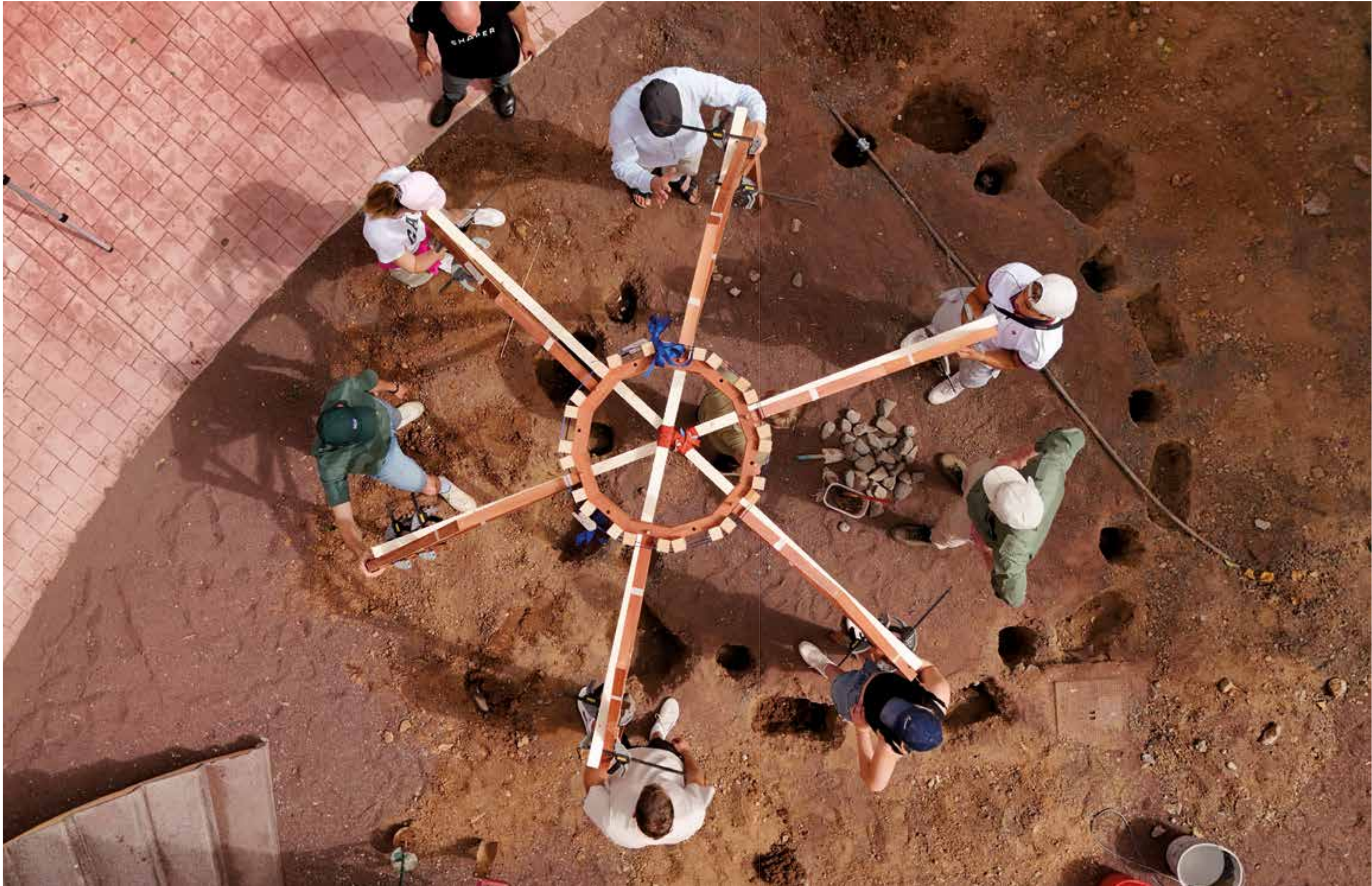
Noch unterstützen die Dachlatten das lockere Gestell, bevor es durch Fundamentierungen und eingespannte Sprossen die nötige Steifigkeit findet.
