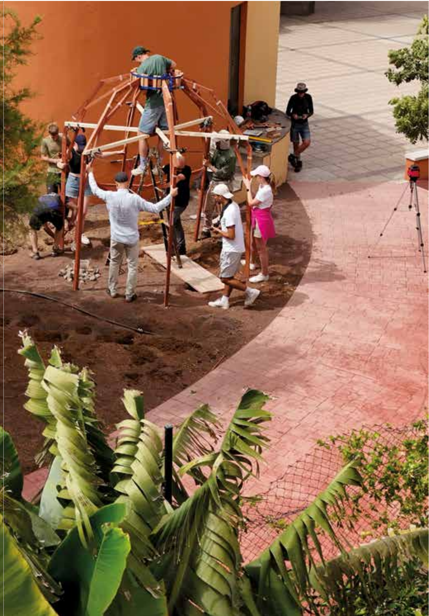
Gemeinsam wurden die perfekten Fügungen der Holzelemente überprüft und die Fundamentierungen vorbereitet.
