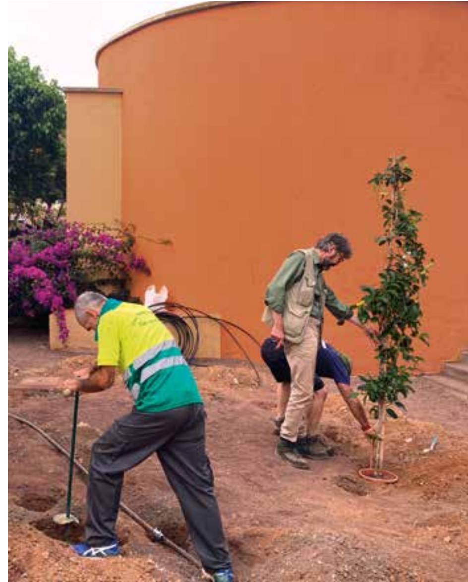
Der Druckring wurde gemeinsam für die Endmontage vorbereitet. | Für die Bepflanzungen wurden ausreichend große Pflanzlöcher ausgehoben, damit die Wurzeln genug Platz finden können. Die Löcher für Fundamentierungen liegen dazwischen.
