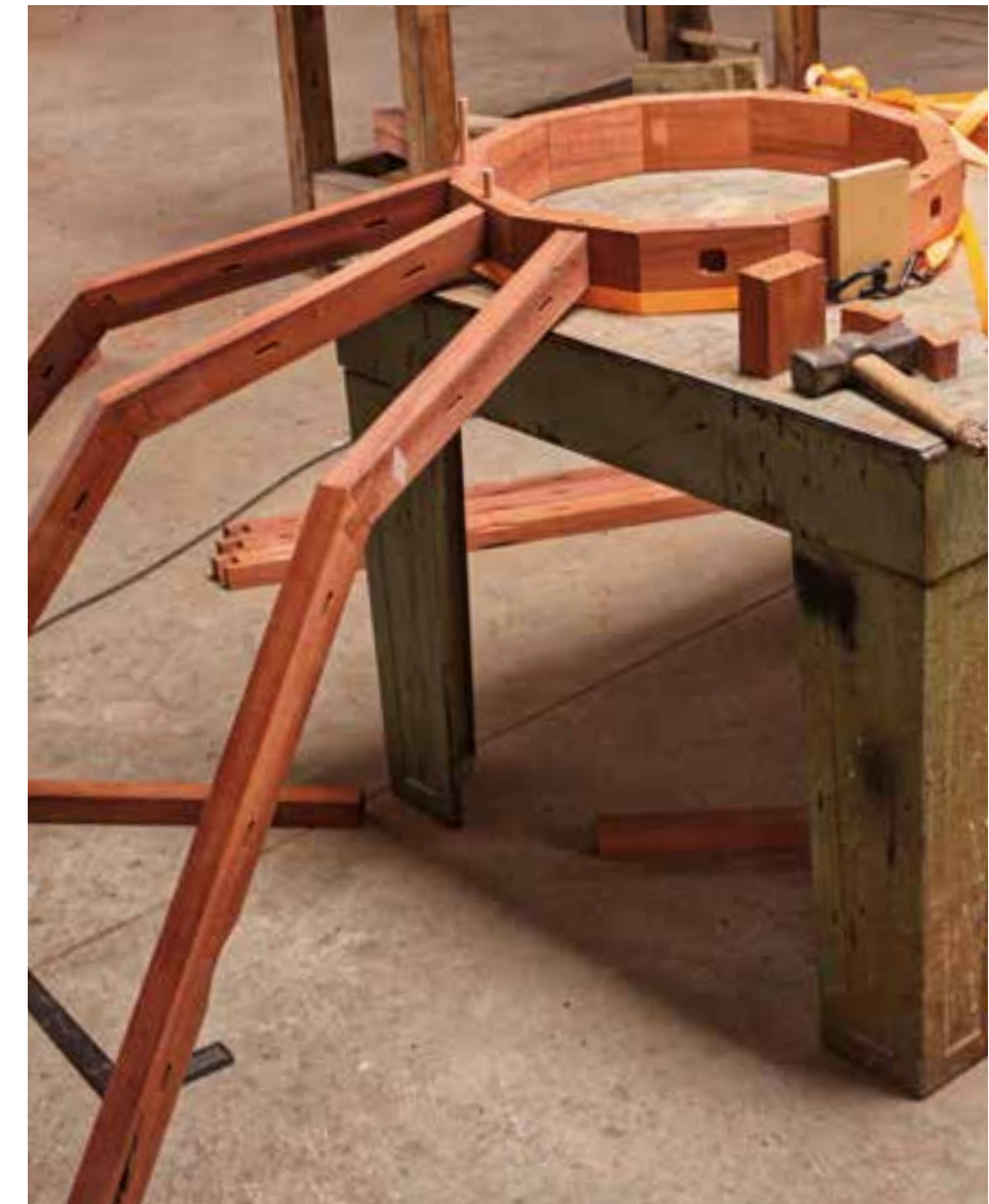
Butterflys werden passgenau mit Zulage eingeschlagen. | Die oberen Teile der Stützelemente werden in einem ersten Test mit Dübeln an den Druckring gehängt.
